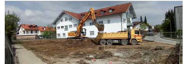
Am Schmiedweg haben jetzt endgültig die Bauarbeiten für eine KiTa in Holzmodulbauweise aus zwei Krippengruppen für je 12 Kinder, eine Kindergartengruppe für 25 Kinder und einer integrative Kindergartengruppe für 16 Kinder begonnen. Bezugsfertig soll die KiTa Ende des Jahres werden. (Foto: Peter Pernsteiner)
