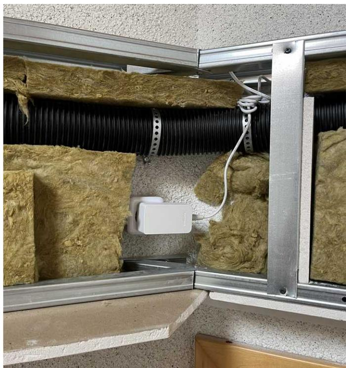
Nach der Verlegung der Rohre wurde diese durch einen Trockenbauer verkoffert. Dabei haben wir z.T. Lichtbänder eingebaut. ( Foto: Sterner)
