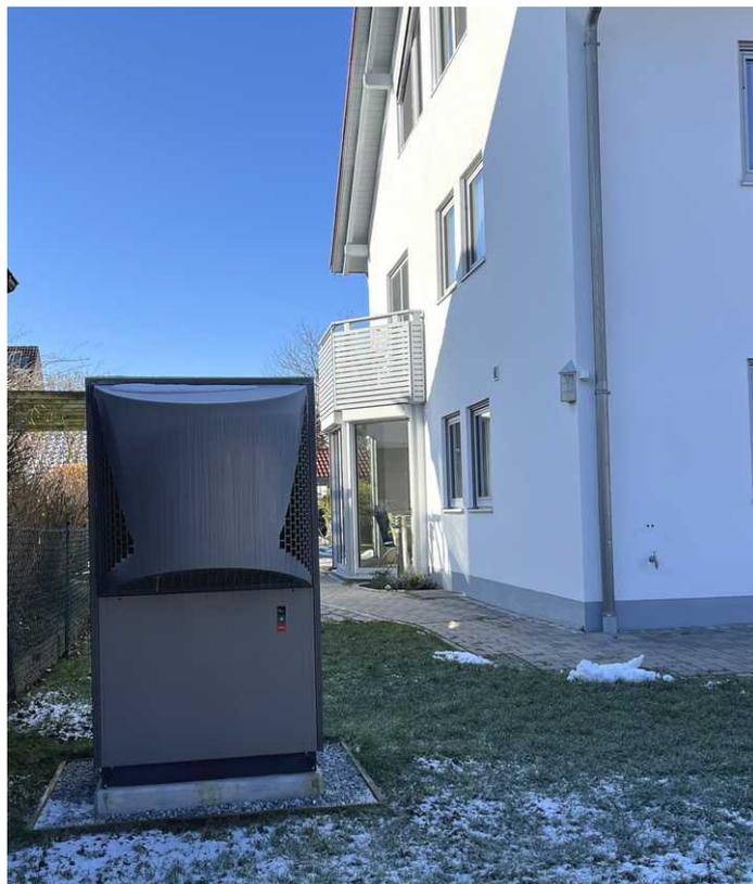
Die Wärmepumpe, wie sie heute dasteht. Im Hintergrund ist vor dem Erker das Edelstahlrohr der Frischluftansaugung der Lüftung zu sehen. Diesen Standort haben wir gewählt, weil links von der Wärmepumpe auf dem Nachbargrundstück ein Gartenhaus steht, was zur Schallabschirmung beiträgt. Vom Nachbarn haben wir das Einverständnis eingeholt, den vorgeschriebenen Abstand von 3,5 m zur Grundstücksgrenze unterschreiten zu dürfen. Wir haben jetzt ca. 70 cm Abstand.
